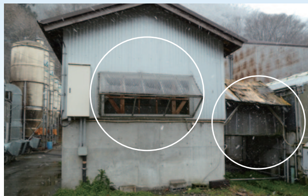
肥育舎B棟北側の炭脱臭装置改修予定箇所
