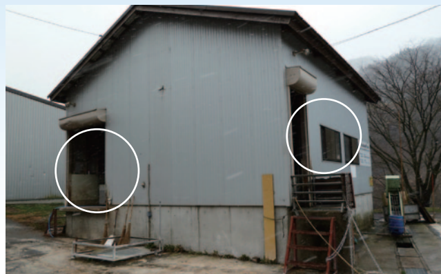
出荷出口待機場のエアカーテン導入予定箇所
