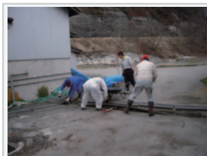
排水路清掃作業
