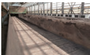
平成 25 年 5 月 2 日現在の堆肥舎攪拌層の状況
