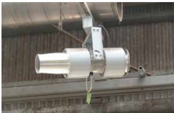
新設した「誘引ファン」
